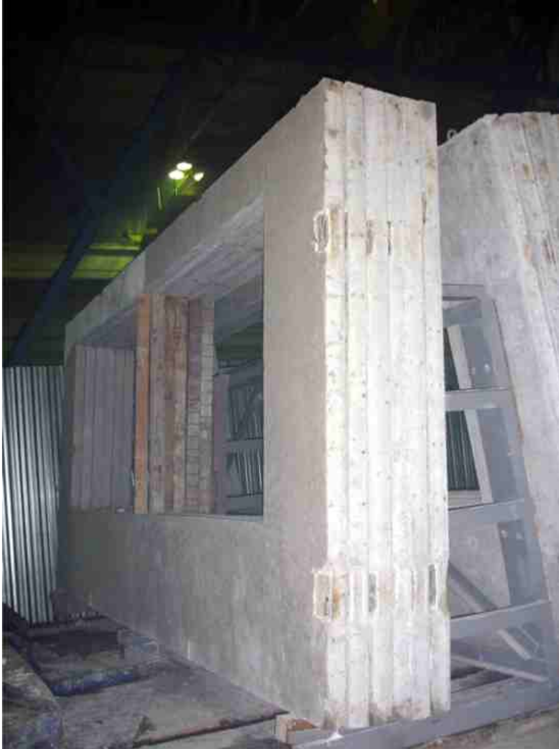
Склад готовых изделий ВС для здания с вентилируемым фасадом и сборно-монолитным каркасом. 2009 г. С.-Петербург
