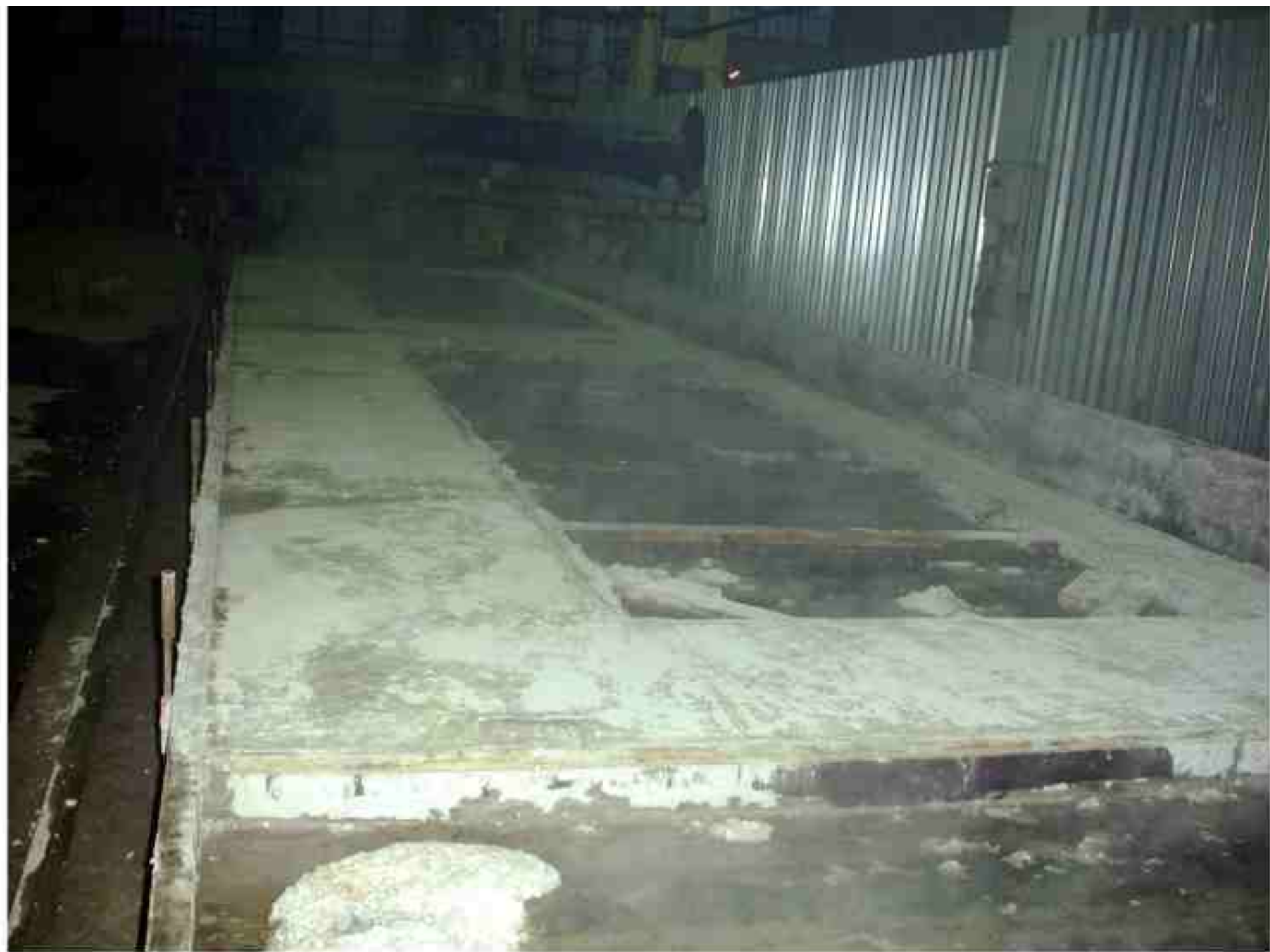
Формовка ВС для здания с вентилируемым фасадом и сборно-монолитным каркасом на универсальном стенде. .2009 г. С.-Петербург
