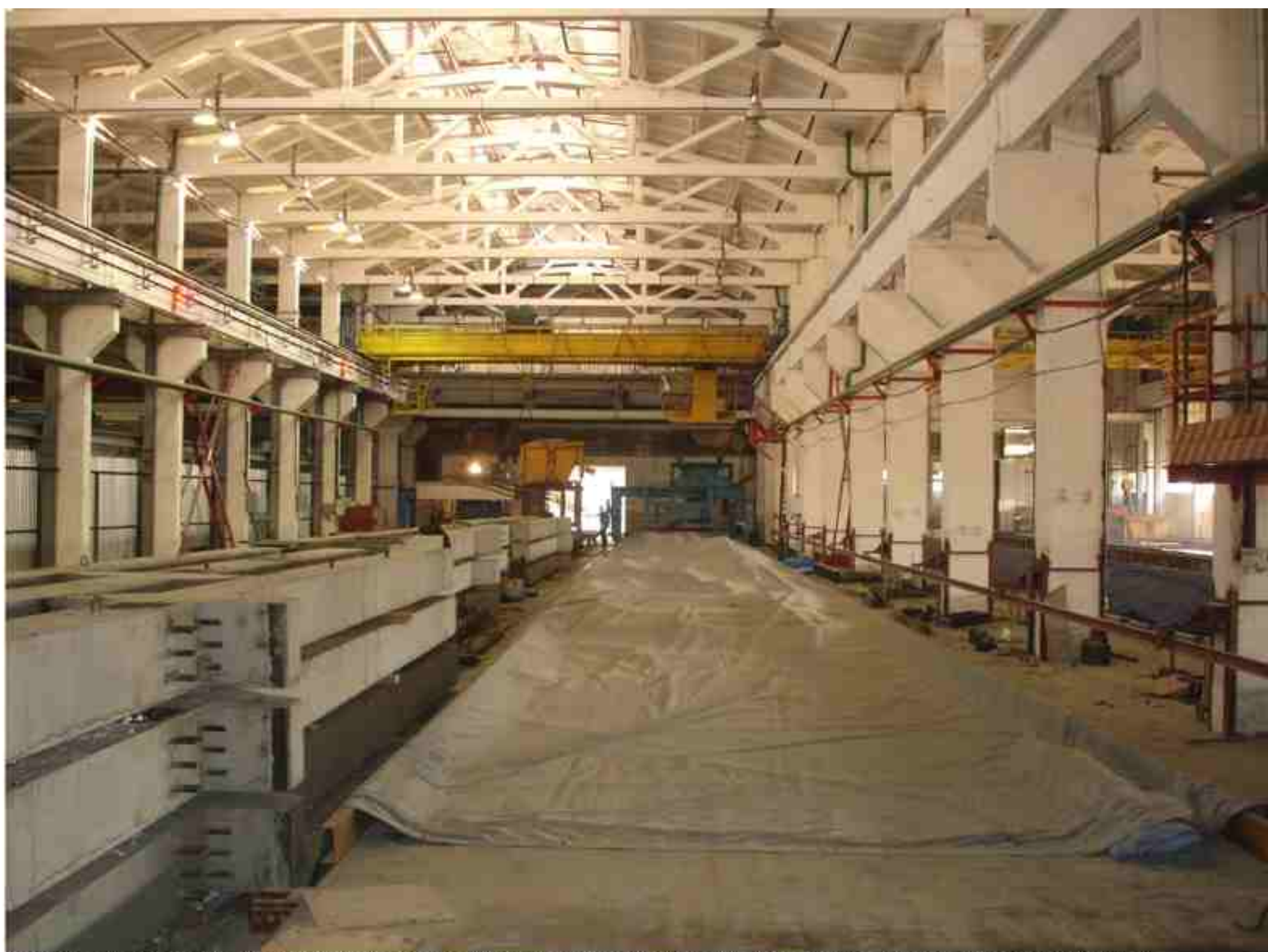
Универсальный стэнд 4.0 x 90.0 (м) оснащенный под выпуск колонн зданий промышленного назначения Сентябрь 2009 г. Челябинск. гр. компаний "ДЭФА"
