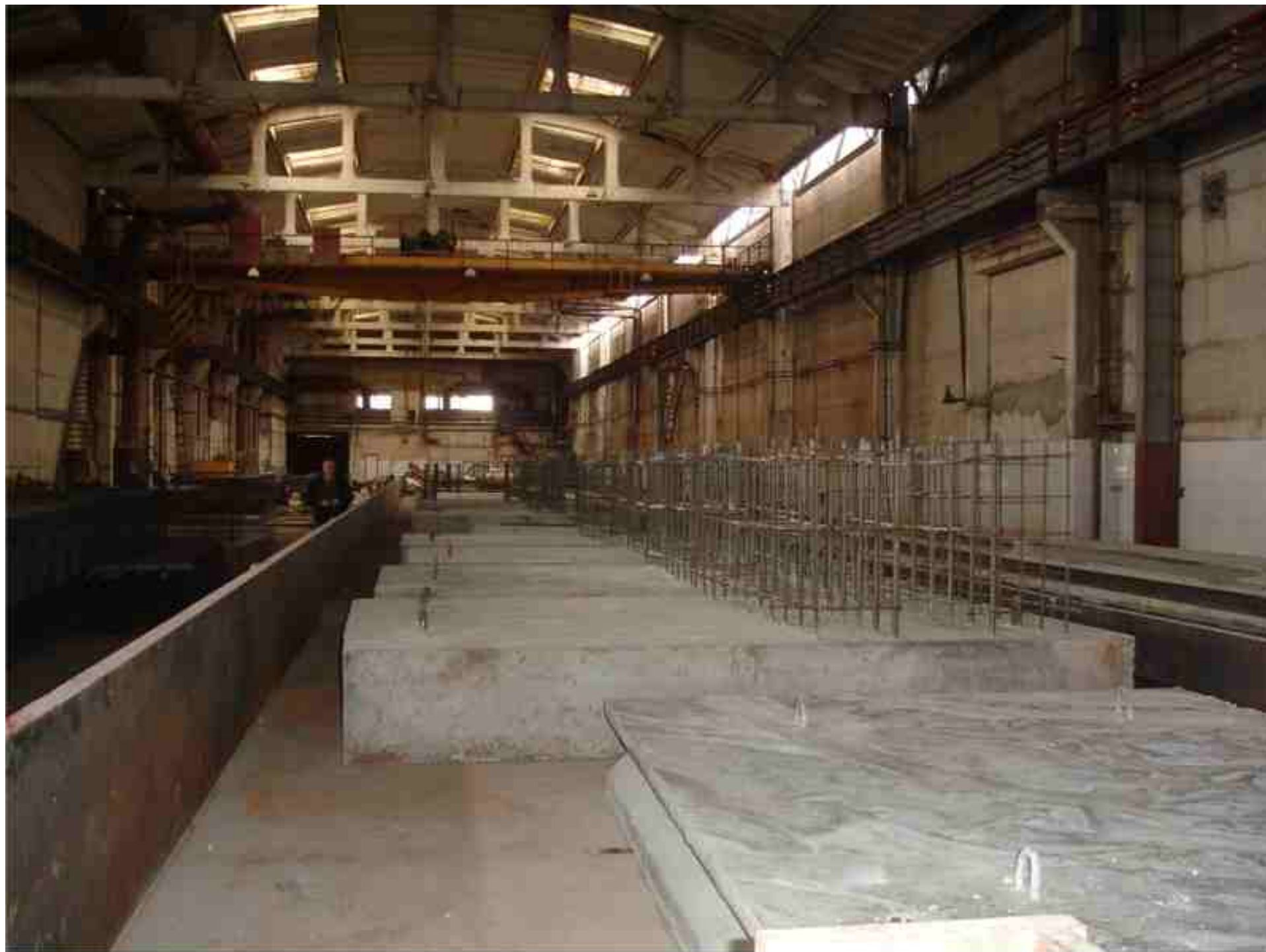
Изготовление сборных железобетонных конструкций промышленного назначения на универсальном стенде. ЗАО "Рекон" г. Чебоксары, 2009
